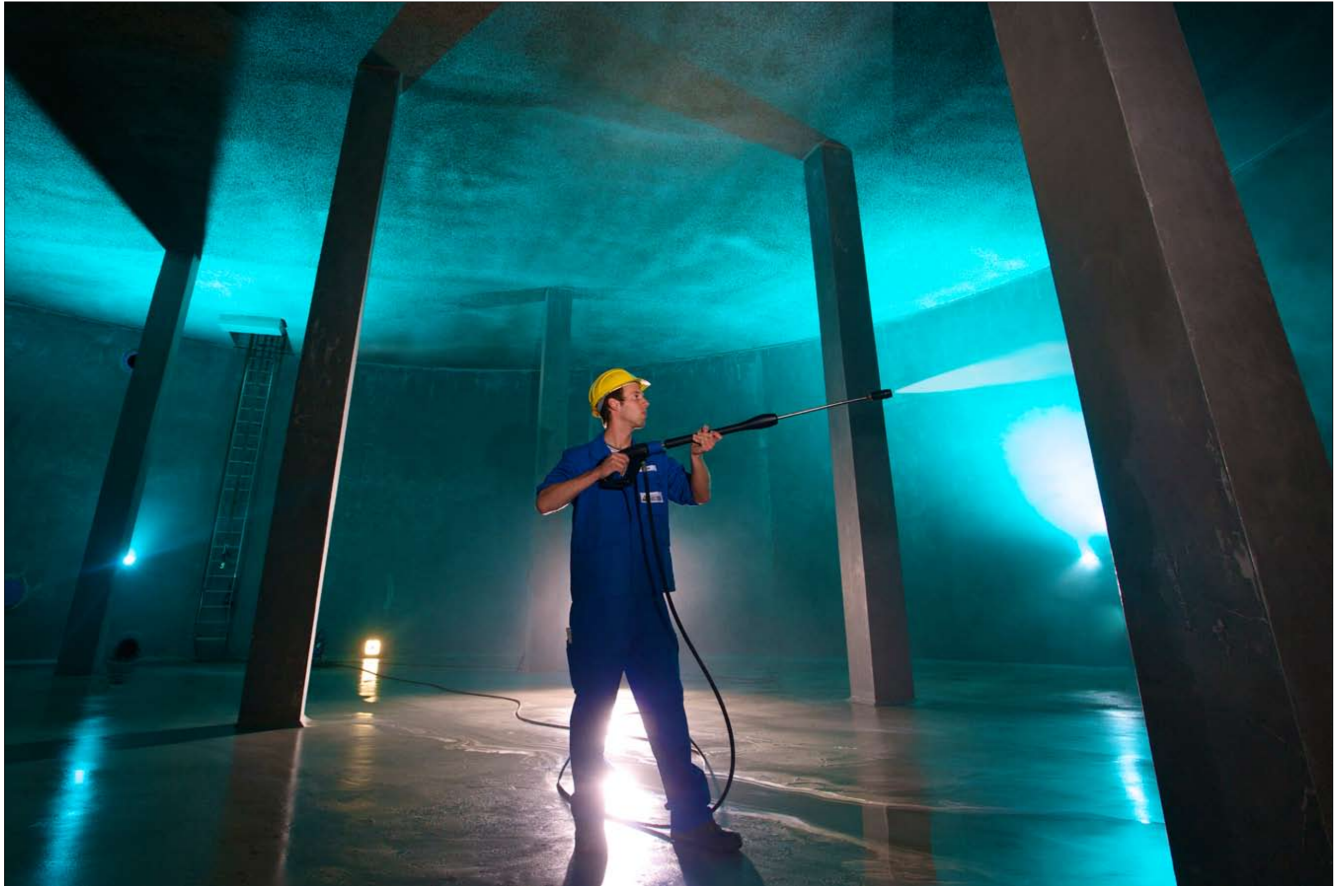
Beruf: Anlagenmechaniker Location: Stadtwerke Troisdorf, Trinkwasserspeicher.
