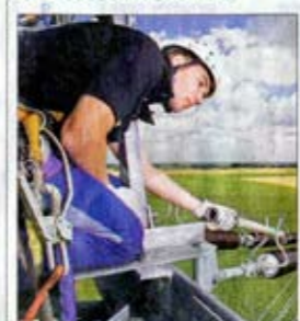
Sven Majhen bei der Arbeit auf einem Strommast
